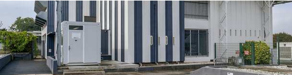
La première tranche de l'extension du datacenter TDF de Bouliac va permettre de doubler la capacité actuelle de l'équipement (Crédits : Reuters)
